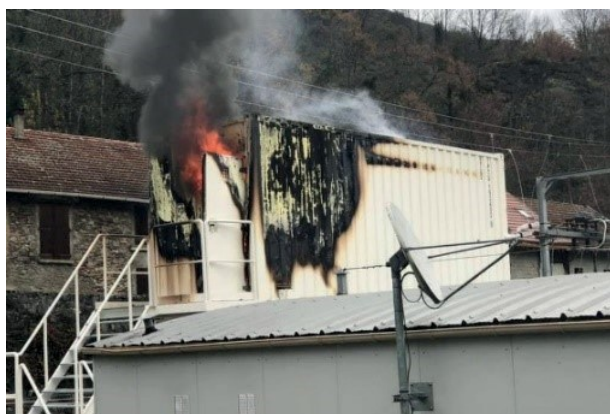
Exemple : sinistre d'un container de stockage d'énergie
