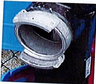
Poteau d'aspiration de 100mm, muni d'une sortie de 100mm, avec raccord fixe
