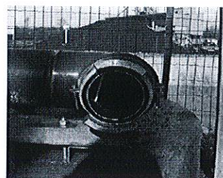
Une sortie de 100mm avec les tenons verticaux (l'un au-dessus de l'autre)
